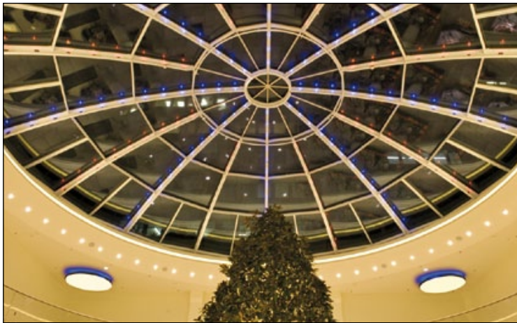
Selbst die Decken sind in diesem Einkaufszentrum – Lentia in Österreich – mit LEDs ausgestattet: „Es handelt sich um Eigenentwicklungen, um einzelne DMX-Leuchten mit 3-Watt-LEDs“, beschreibt Jürgen Lagerbauer „Sie haben jeweils eine eigene temperaturabhängige Leistungssteuerung. Jede LED entspricht einem Pixel – wie bei einer Videowand.“
